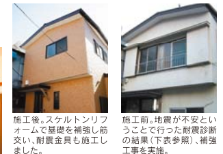
施工後。スケルトンリフォームで基礎を補強し筋交い、耐震金具も施工しました。
