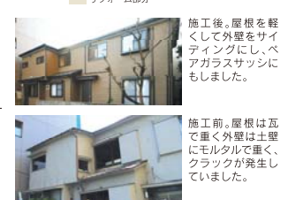
施工後。屋根を軽くして外壁をサイディングにし、ペアガラスサッシにもしました。
