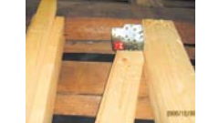
補強計算し耐力の足りない所へ新しい筋交いを専用金物で補強
