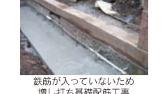
鉄筋が入っていないため増し打ち基礎配筋工事
