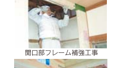
開口部フレーム補強工事
