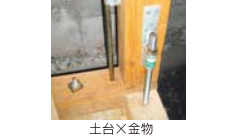
土台×金物 ホールダウン金物補強工事
