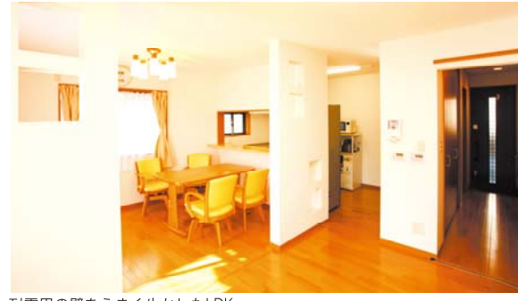
耐震用の壁をうまく生かしたLDK ダイニングとリビングの間には耐震用の壁が必要だったため、一続きにできなかったが、壁に窓を開けることで閉鎖的な感じを与えないようにしました。
