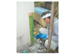
地震の揺れで柱が引き抜かれないように「アラミド繊維」で基礎と柱を固定
