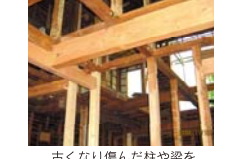
古くなり傷んだ柱や梁を取り替えて新しくした
